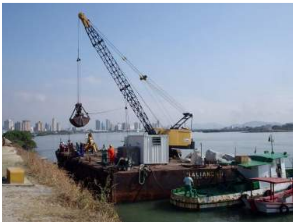
Figura 81. Conjunto de equipamentos de derrocagem e embarcações de apoio
