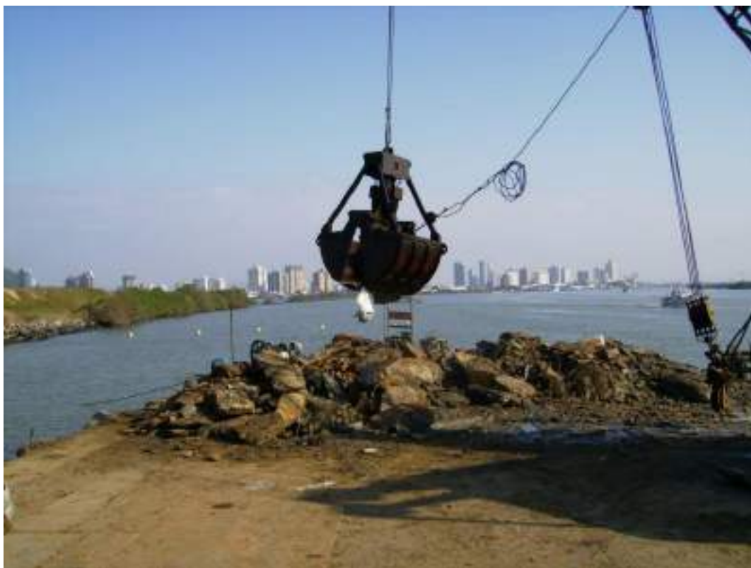
Figura 82. Carga de material derrocado, com guindaste e clam shell
