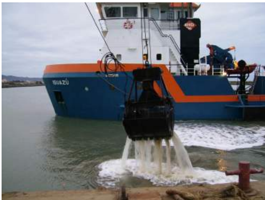
Figura 87. Escavação de material derrocado
