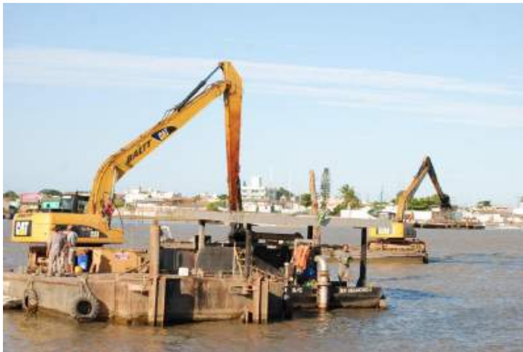
Figura 79. Escavadeira hidráulica operando em cima de flutuante
