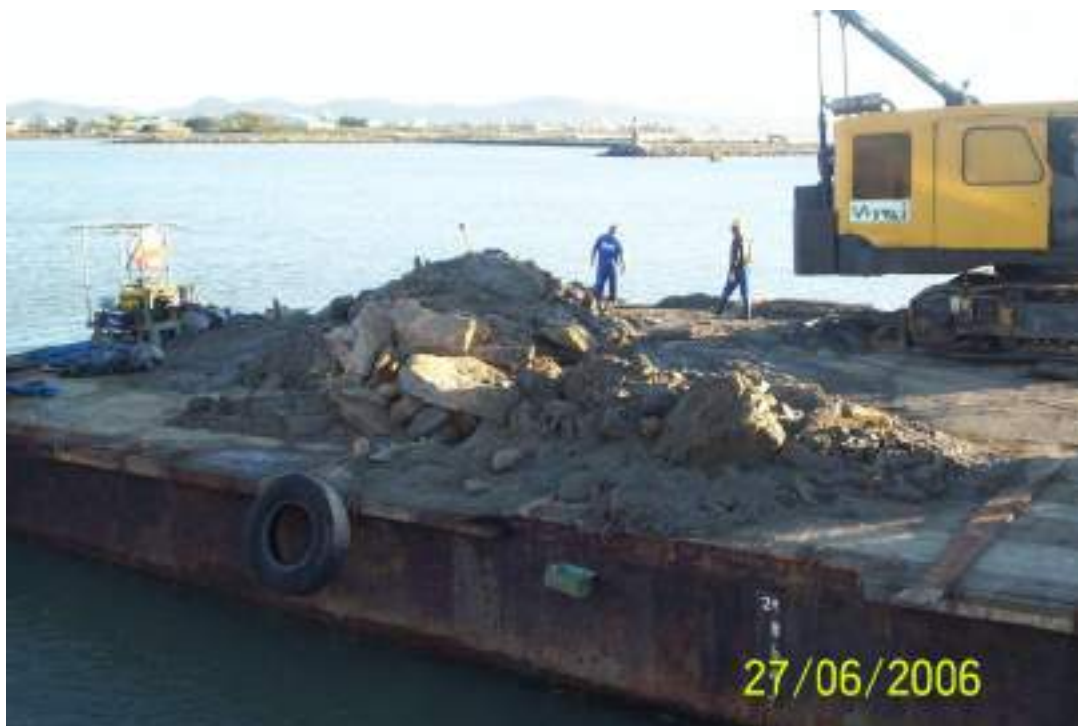
Figura 83. Vista de material derrocado no flutuante
